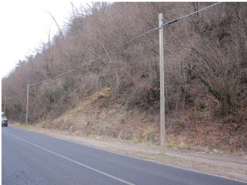
Fotografia 3: Strada adiacente il dissesto, ma non interessata dalla zona d'accumulo, fermatosi a lato strada.
