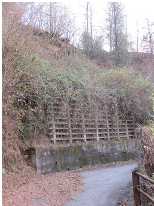
Fotografia 4: Barriera in elementi prefabbricati a protezione del tracciato stradale.
